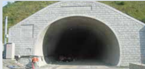
新風吹 トンネル工事
