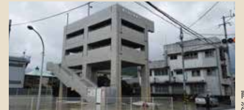
南方地区 津波避難タワー
