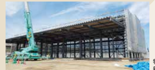
物流センター 新設工事
