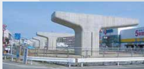
497号拾六町 高架下部工事
